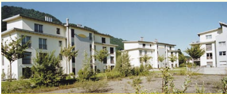
Wohnsiedlung „Chrüzwiess“, Reichenburg
